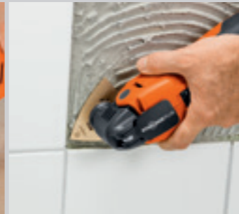
A keményfém ráspoly lesimítja a csempéragasztót, és gondoskodik a sík aljzatról.
