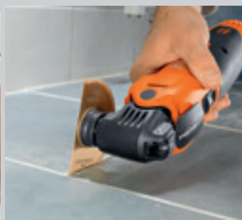
A mindössze 1,2 mm széles fűrészlapokkal a nagyon keskeny hézagok is kivághatók.
