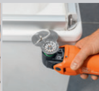
A rugalmas tömítőanyagok tökéletesen eltávolíthatók az újrafugázás előtt.
